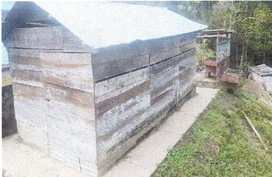
**Foto 3: Cocina en mal estado sin ventilación**
